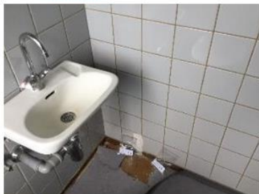
Billede 2a og 2b: Badeværelse uden asbestholdigt fliseklæb
