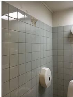
Billede 1a og 1b: Badeværelse med asbestholdigt fliseklæb
